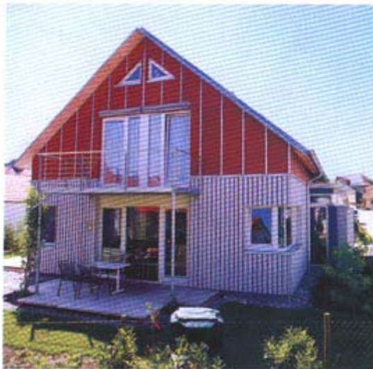
Für die Kinderzimmer im Dachgeschoss wurde ein Stahlbalkon vorgestell, der gleichzeitig als Überdachung und Sonnenschutz für den ruhigen Essplatz auf der Holzterrasse dient.
