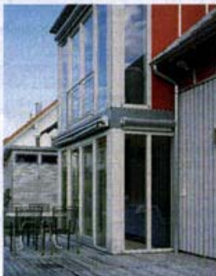
Sonnenseite. Rollläden und Markisen auf der Südseite sind elementar, damit das Haus im Sommer nicht überhitzt.
