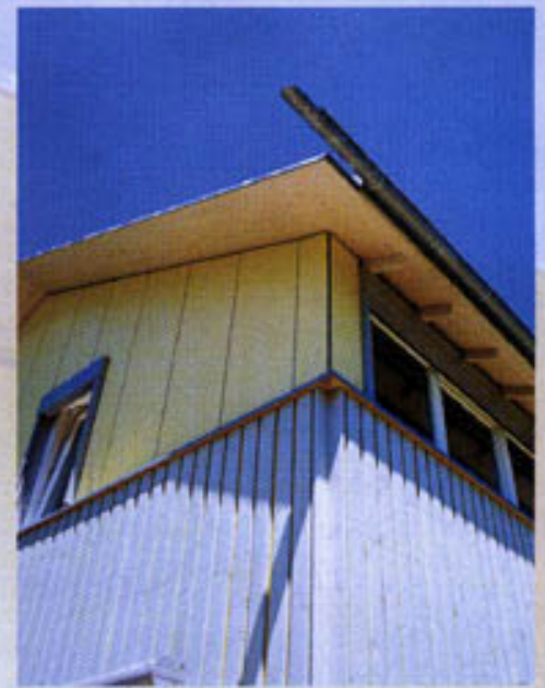
Holz im Außenbereich: Von der Fassadenverkleidung, einer Boden-Deckel-Schalung in gelb gestreiftem Grau, bis zur großen Holzdielenterrasse. Am Giebel sorgen gelbe Faserzementplatten für den perfekten Kontrast.
