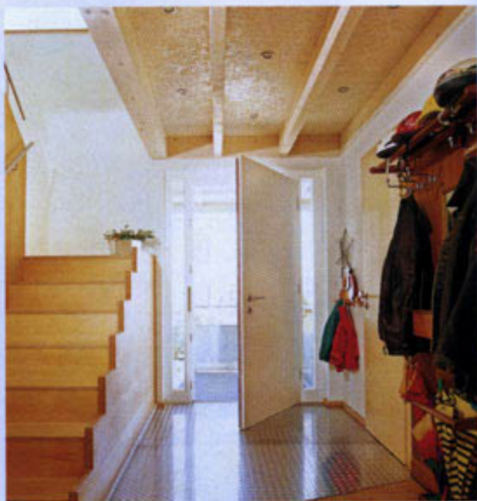
Holz im Innenbereich: Treppe, Fußboden, Balkendecke, Türen und Fenster. Dazu ein ganz praktischer Material-Mix: Die schräg zulaufende Metallplatte schützt vor Schmutz und Nässe.
