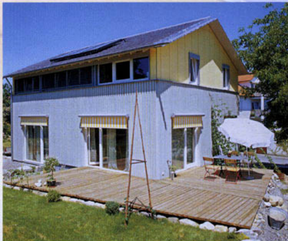
Holz im Außenbereich: Von der Fassadenverkleidung, einer Boden-Deckel-Schalung in gelb gestreiftem Grau, bis zur großen Holzdielenterrasse. Am Giebel sorgen gelbe Faserzementplatten für den perfekten Kontrast.
